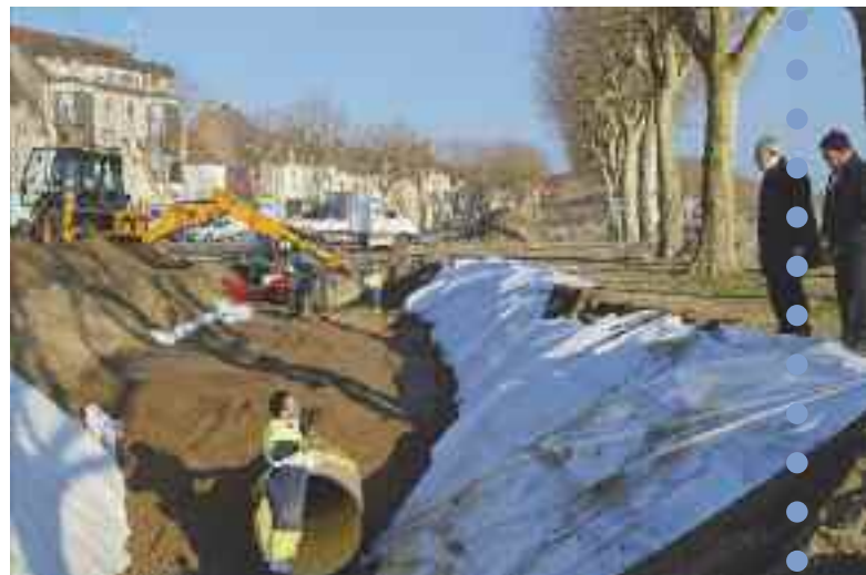
Les travaux d'assainissement se poursuivent
